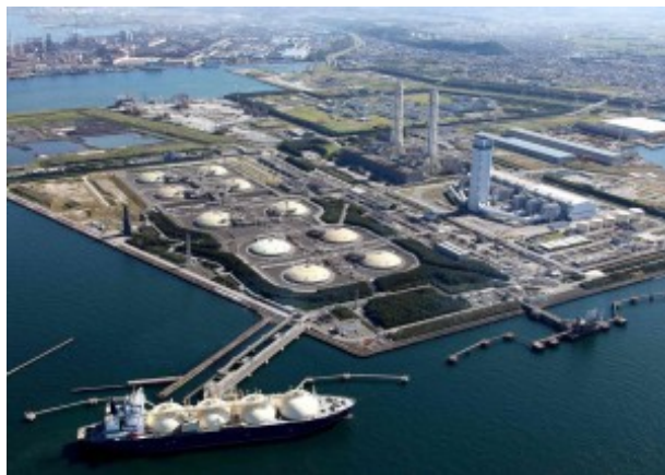
Exemple de complexe LNG
